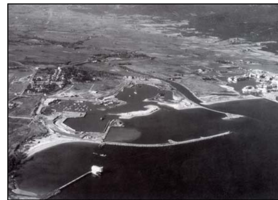
La construction des Marines de Cogolin en 1968 Source : « Cogolin », Fondation historique Sellier – 1989
