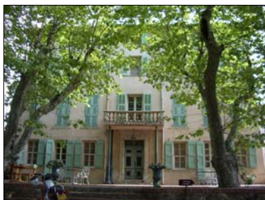
Le Château des Garcinières Source : Citadia Conseil
