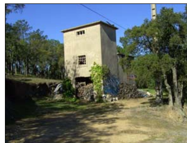
L'ancien bâtiment des mines Source : Mairie de Cogolin
