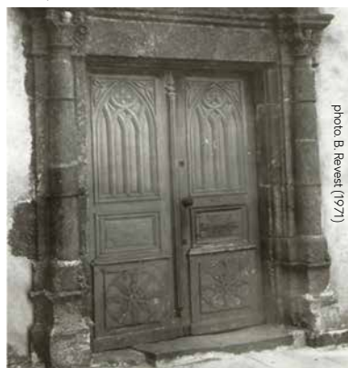
• porte latérale de l'église (Photo B.R.)
