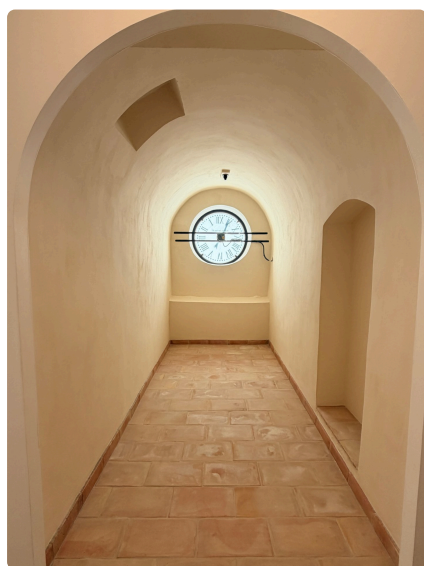
Le passage vers l'horloge, sous sa voûte restaurée.
